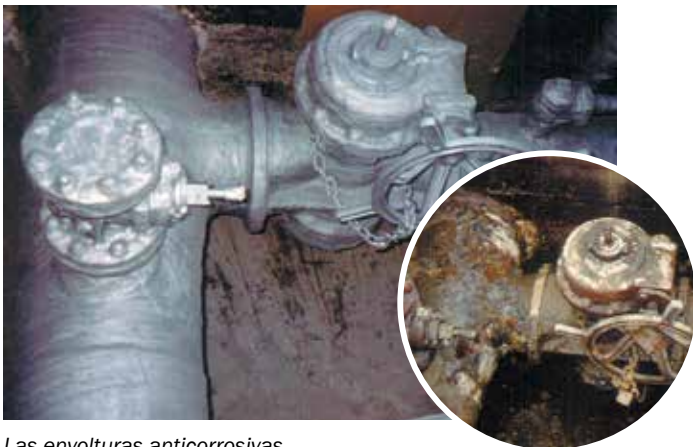
La cinta Wax-Tape® #1, protege todo tipo de conexiones de geometrías irregulares enterradas y es compatible con la protección catódica.
