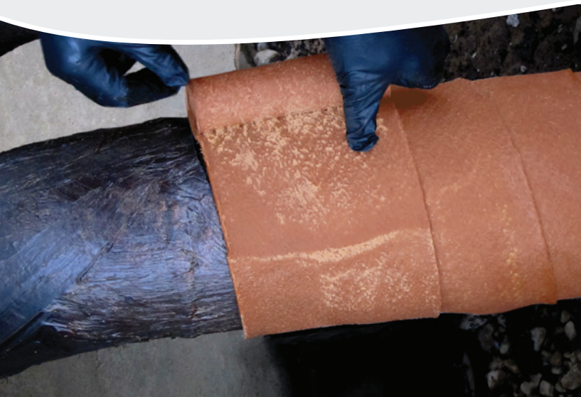
Un sistema de protección fácil y rápido para aplicaciones de alta temperatura, HT-3000 Wax-Tape requiere una preparación mínima de la superficie
