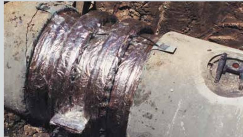
Poly-Ply es un revestimiento de plástico multi-capa. Ayuda a mantener una separación entre la cinta y el suelo.
