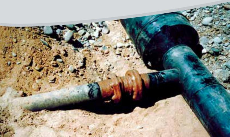
*Wax-Tape #1 de Trenton proporciona protección duradera y es compatible con muchos tipos de materiales como acero, hierro y PVC.*
