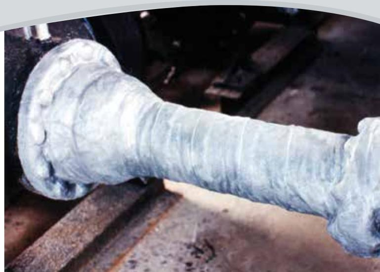
*Una tubería que suda es protegida con Wax-Tape #2 demostrando la capacidad de protección en condiciones de humedad.*
