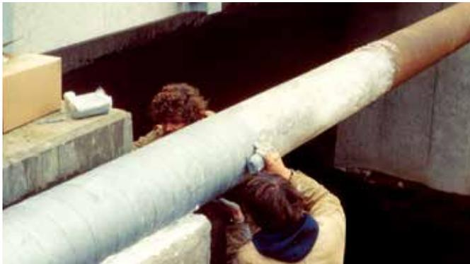
Aquí Wax-Tape #2A de Trenton se está aplicando sobre el Imprimador Wax-Tape (blanco). Observe que el Imprimador Wax-Tape se puede aplicar a la tubería después de una mínima preparación de la superficie.
