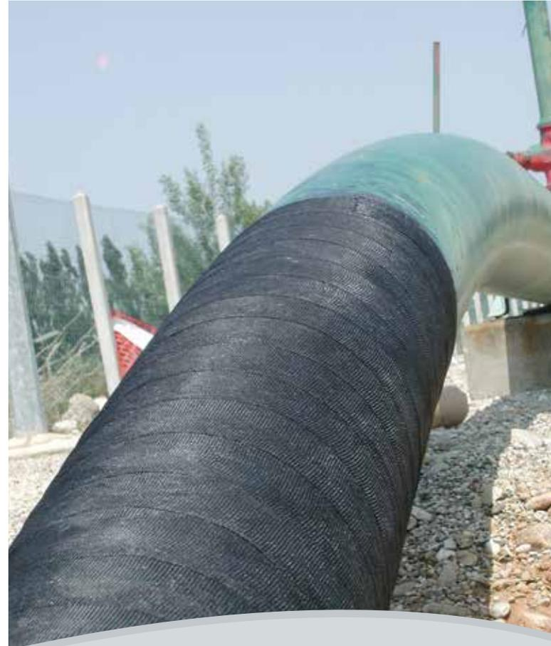
▲ El "MC" en MC significa "moisture cured", en español "curado por la humedad". Los materiales en el revestimiento empiezan a curar cuando están expuestos a la humedad del aire. El revestimiento proporciona una protección muy resistente al exterior.
