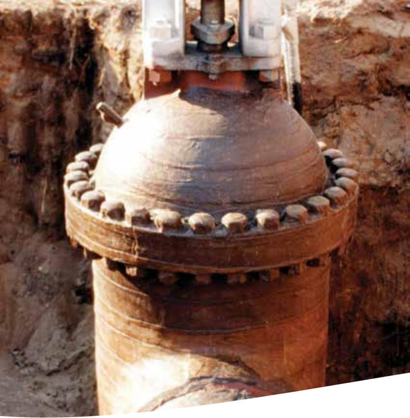
◀ Los clientes se han impresionado al retirar un pequeño trozo de Wax-Tape Trenton para inspeccionar: encontraron la superficie en las mismas condiciones en las que se encontraba cuando esta fue aplicada por primera vez. Después de la inspección, el pequeño parche puede ser colocado de nuevo para continuar la protección.
